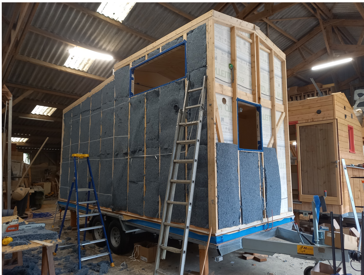
Tiny House en construction dans l'atelier de Ty Rodou
